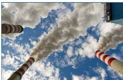
Abb. 4: Technische Anlagen wie Kamine und ...
